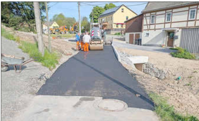
Asphalteinbau am 18. Mai 2026
